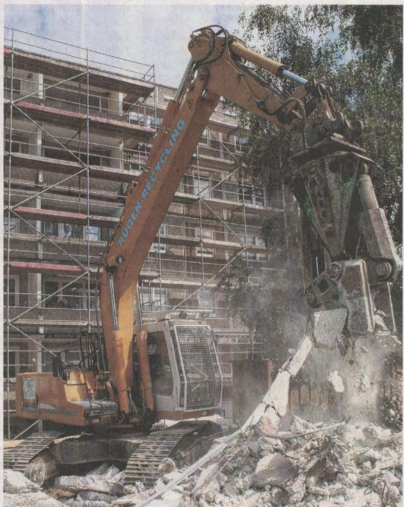
Diese Fünfgeschosser in Bergen-Rotensee ließ die BeWo vor sieben Jahren zu dreistöckigen Wohnhäusern umbauen. ARCHIV-FOTO: ANDREAS MEYER
