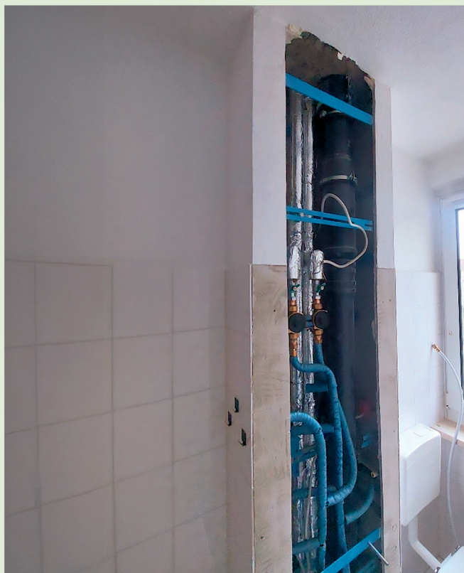
Strangsanierung Straße der DSF 46 und 51
